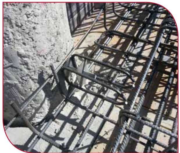
316 logements El Cañaveral, Madrid (Espagne)
