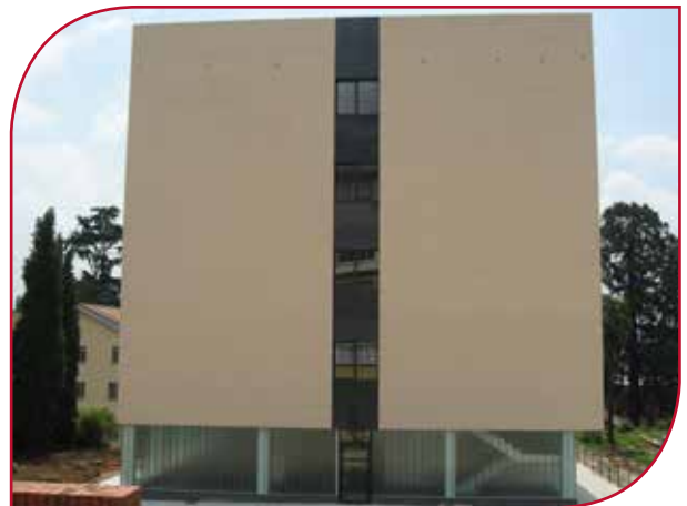
Bâtiment Fundoma à Asturias (Espagne)
