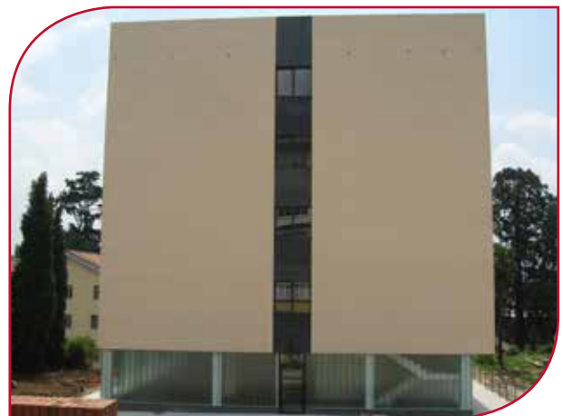
Fundoma Gebäude in Asturien (Spanien)
