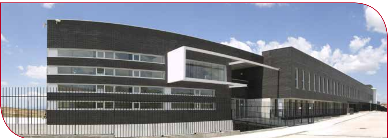
Schulgebäude Montealbir in Guadalajara (Spanien)
